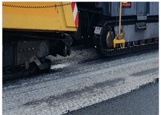
Figure 1 : Présence de lait de chaux pour amélioration de la propreté de l'interface
