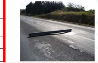
(thermique) Déformation : Type orniérage : déformation dans les band
