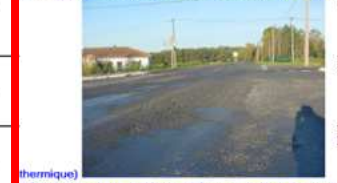
(thermique) Déformation : Type orniérage : déformation dans les band
